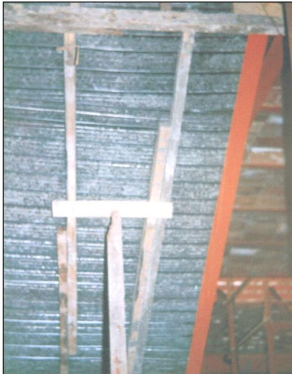
Se pueden llegar a luces de hasta 120 cm. en detrimento de la resistencia del forjado, además de la necesidad de medios auxiliares de sujeción (sopandas y puntales) para evitar la deformación de las placas debido al peso del hormigón.
