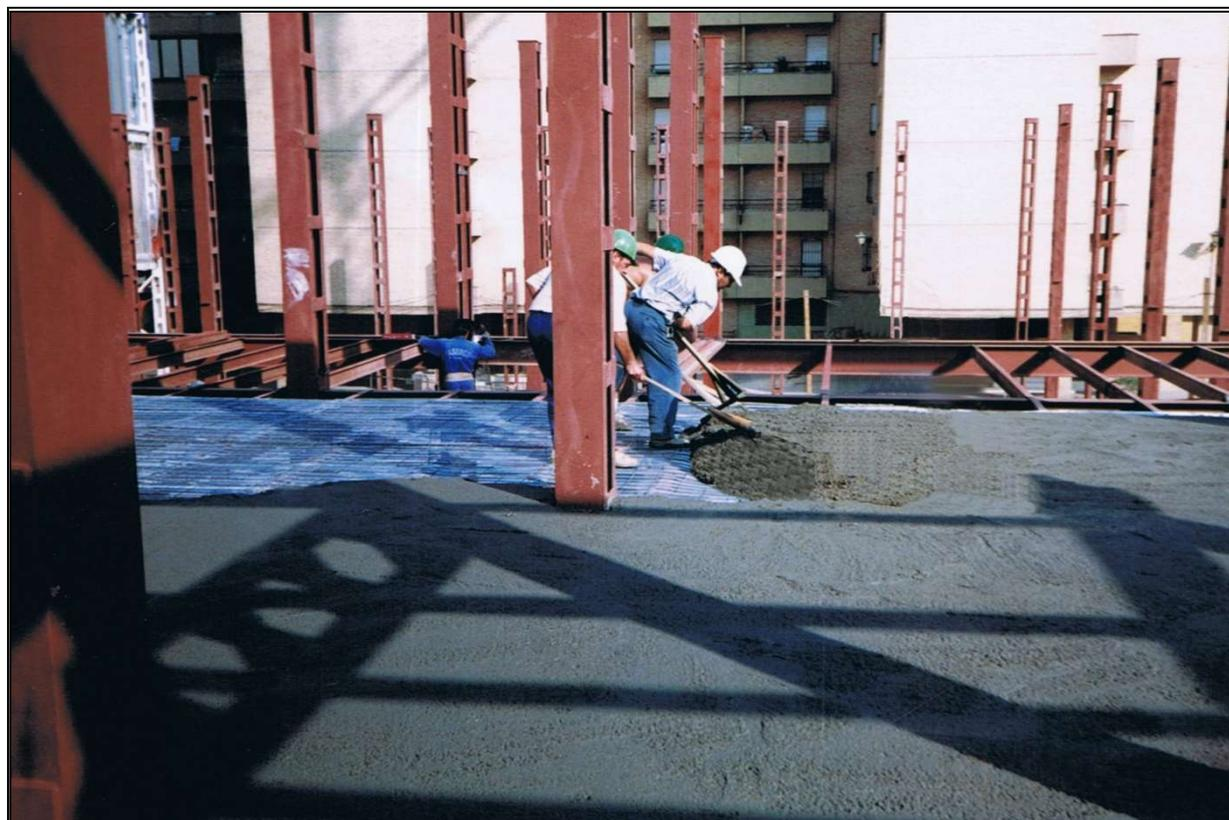
La superficie interior de las cubiertas ejecutadas con PLACNER® favorecen la adherencia de cualquier tipo de revestimiento posterior, ya sea enlucido con mortero, yeso, escayola, etc...
