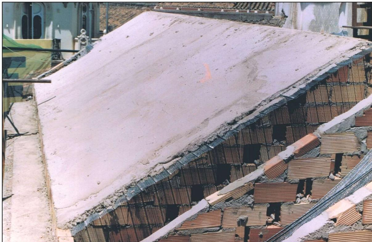
Queda garantizada una losa continua, resistente y sin grietas con una capa de compresión de 3cm. en todo tipo de cubiertas, inclinadas, planas transitables o no, sobre cualquier estructura.
